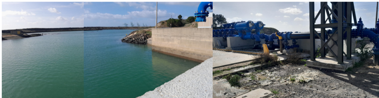
Figura 9 – Bacia de Adução/ Tomada de Água. Fonte: Visita técnica ao Projeto em 30/01/2025.
