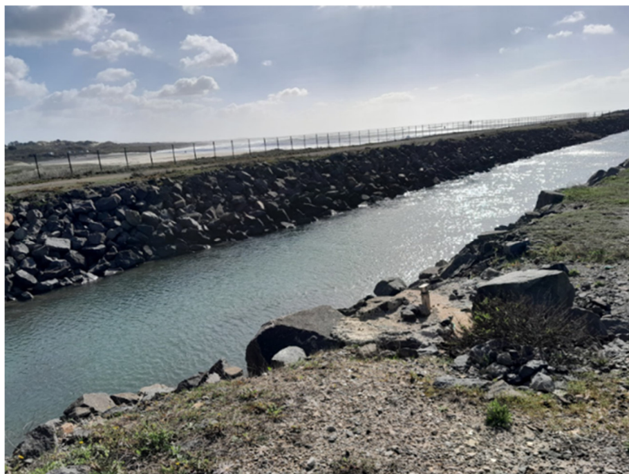
Figura 10 - Canal de Descarga Sul da estrutura de rejeição da antiga CTS. Fonte: Visita técnica ao Projeto em 30/01/2025.
